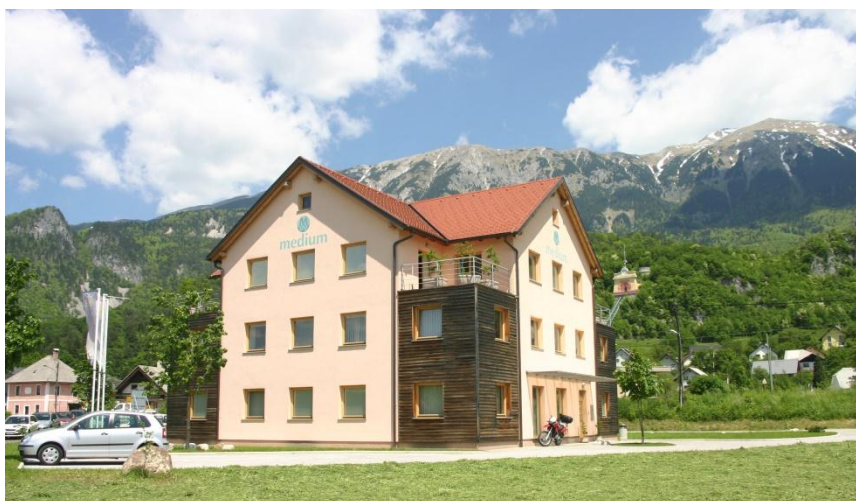
Slika 1: Poslovna stavba podjetja Medium
